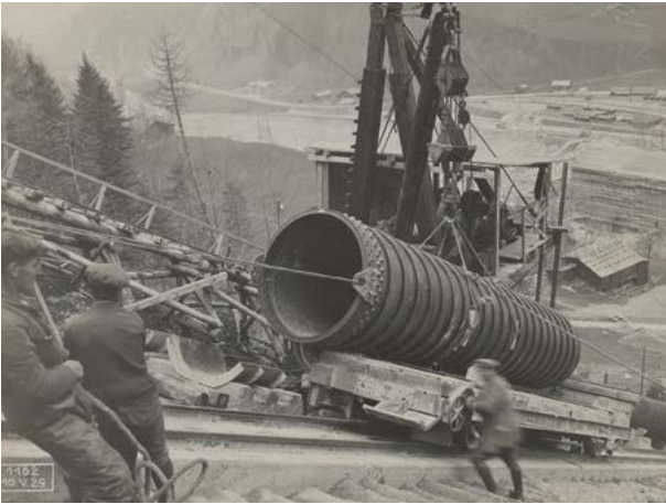
Bau des Vermuntwerks in Partenen, 1929
